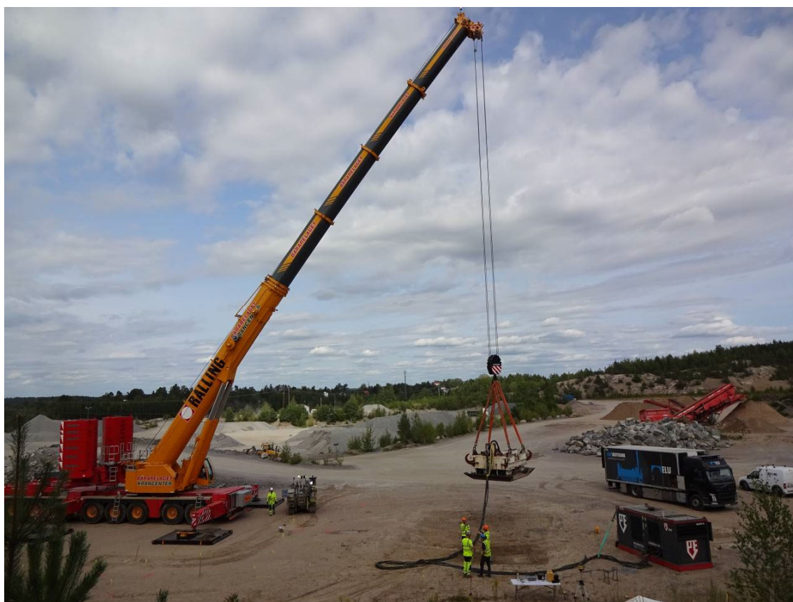
Figur 21. Kran, vibrationsplatta och hydraulpump.
