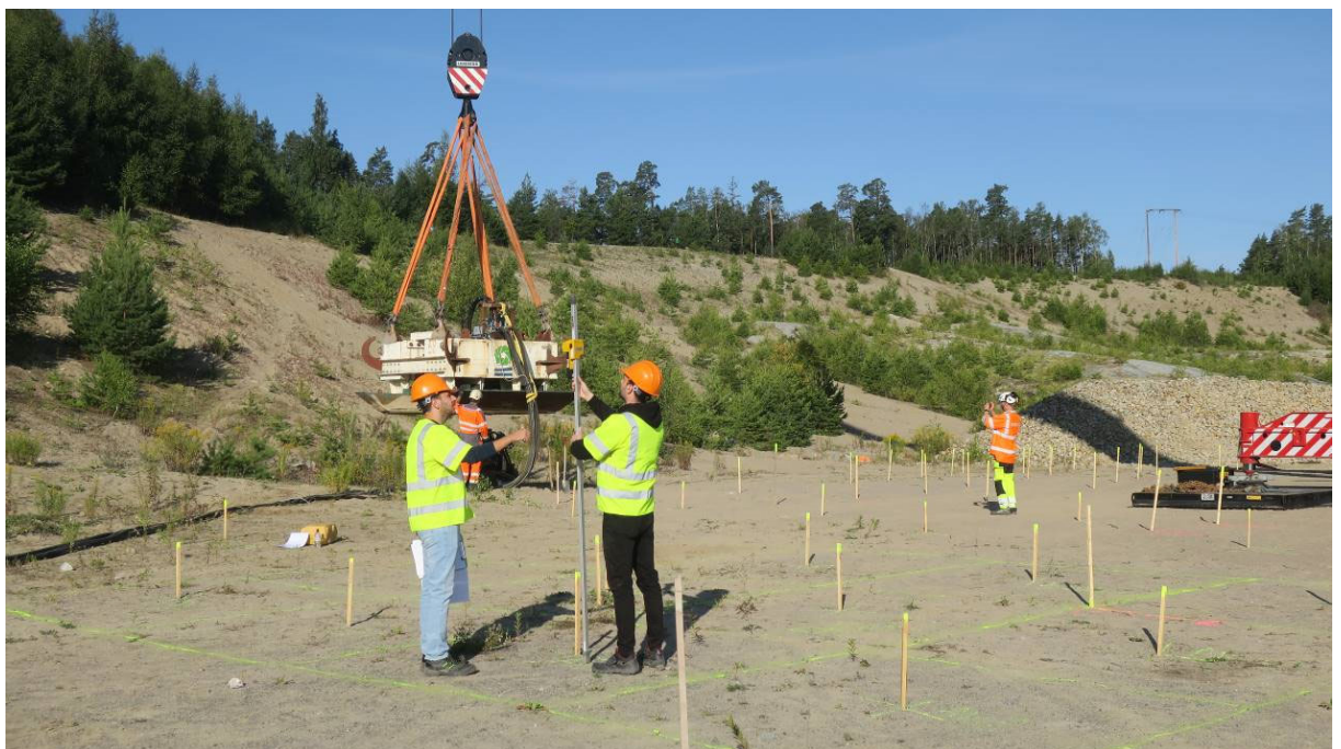
Figur 6. Sättningsmätning med laseravvägning.
