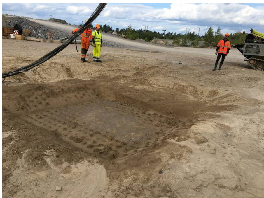
Figur 36. Sättning och hävning efter packning.
